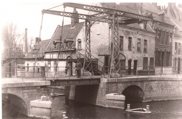
Quesnoy-sur-Deûle, Le pont et la garde, 1916
